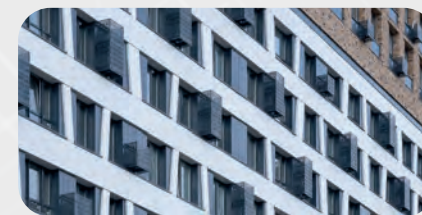
ЖК Рихард г. Москва, ул. Зорге, 9, корп. 2
